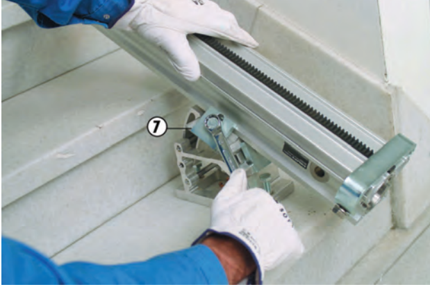
Eğri ve basamaklı kesim tabanı ile ray ayağı montajı
