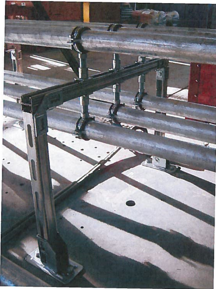
Abbildung 3: Schienenmontagesystem Hilti MQ; Jochmontage 2-lagig
